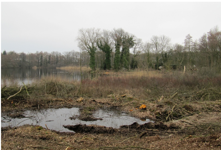
Wiel tijdens eerste herstelwerkzaamheden.
