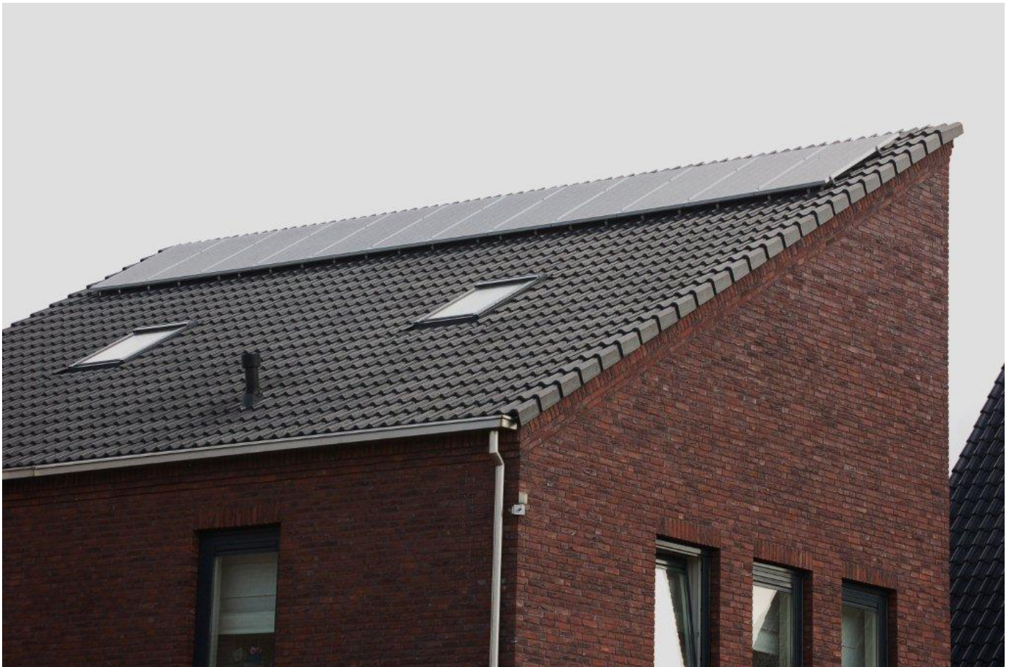
Zonnepanelen op het dak
