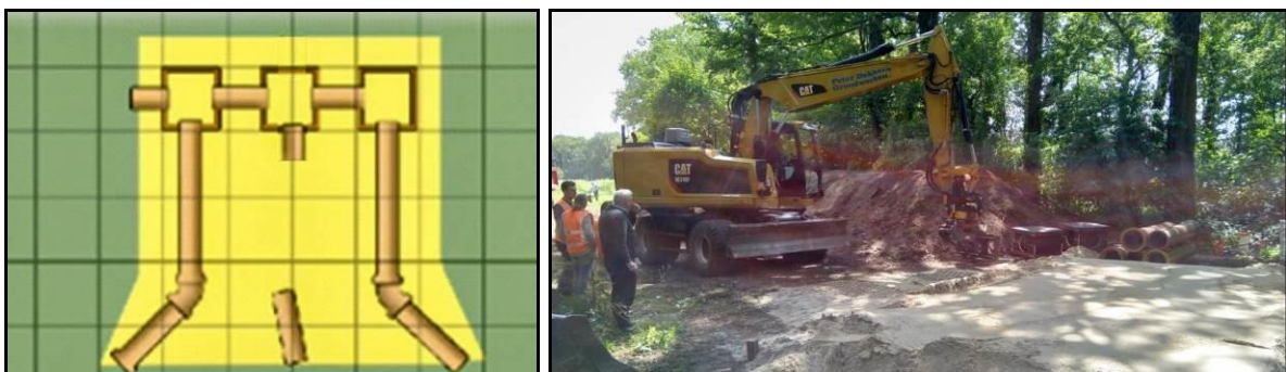
Foto links André: plattegrond kunstburcht met fop pijp. Foto rechts Kragten: de aanleg van de kunstburcht door Peter Dekkers Grondwerken.
