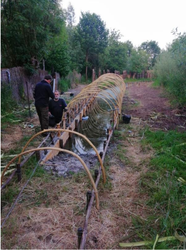
Vernieuwing van het scherpeind van de noordoostpijp
