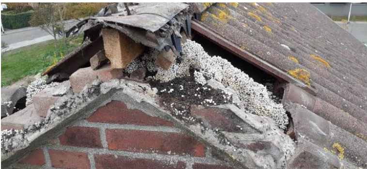
Figuur 3. Voorbeeld van een nageïsoleerde kopgevel waar vleermuizen nog steeds onder de kantpannen kropen
