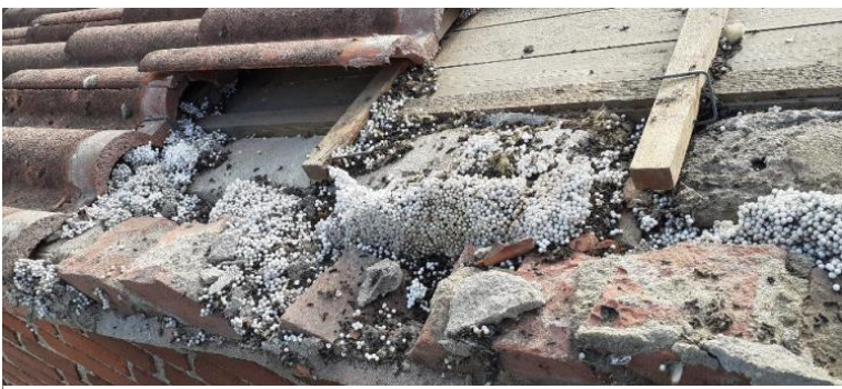
Figuur 4. Tweede voorbeeld van een nageïsoleerde kopgevel (Bergen op Zoom, op een andere locatie dan voorgaande foto) waar vleermuizen nog steeds onder de kantpannen kropen (via de eindnokpan), zoals te zien aan de uitwerpselen.
