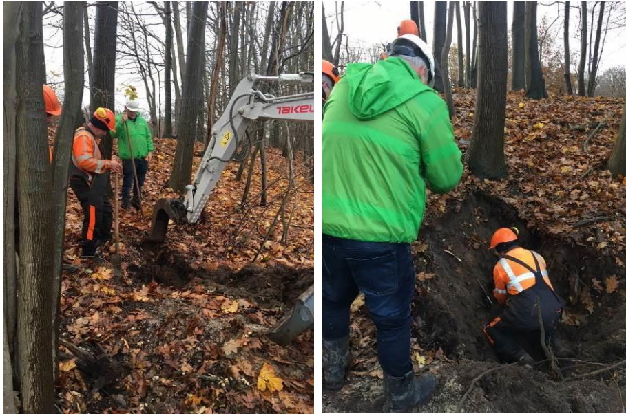
Foto's Bert: het onklaar maken van dassenpijpen in de dijk van het Drongelens kanaal.
