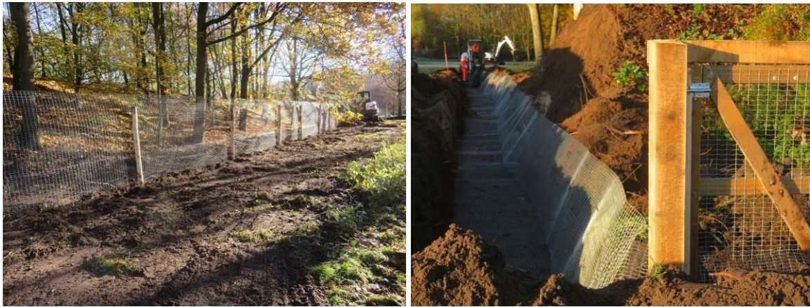
Foto's André. De aanleg van de vangren door Arfman.
